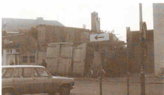
Afbraak schuur naast het restaurant.
