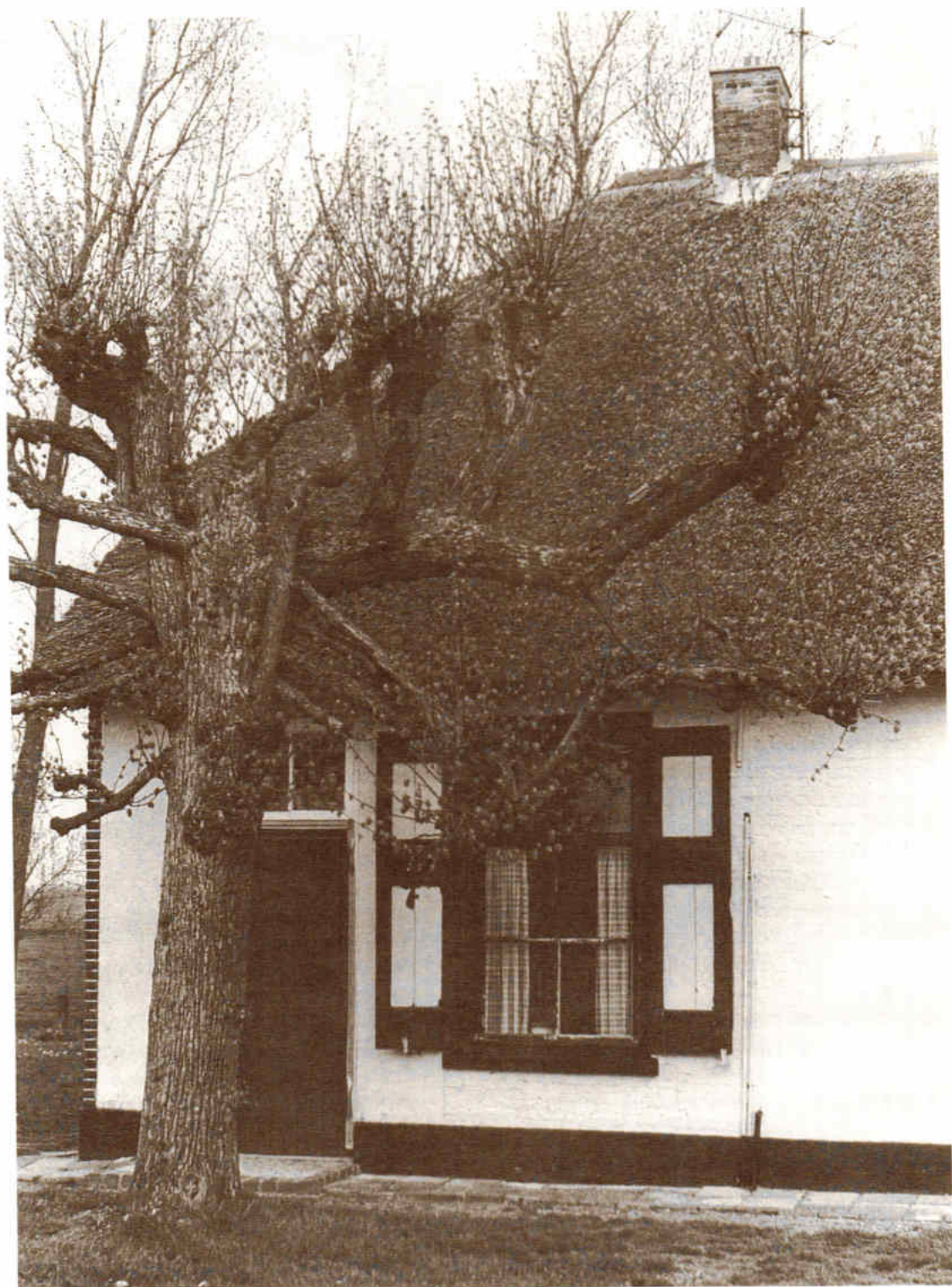
Gedeelte zijkant boerderij Het Iert.
