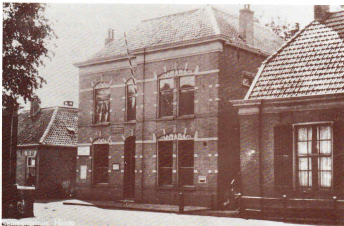
In het midden het huis van de dames Rakhorst en hun broer Gerrit; later het gemeentehuis; nu "The Pub". Links het huis van de familie Offenbergh, dat na de tweede wereldoorlog is afgebroken en waarvoor, meer naar links, een nieuwe woning in de plaats is gekomen. Rechts het pand Canadastraat 6-8.
