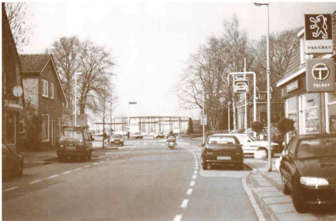
April 1996 - garage annex showroom van R. Lindeboom en Zn in aanbouw.
