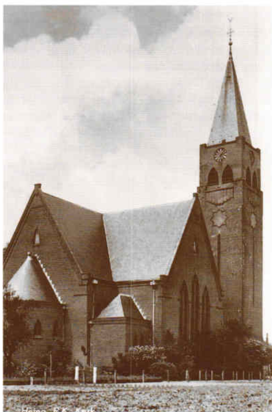
R.K. Kerk - na herstel. De toren is verhoogd en de uurwerken zijn verplaatst.
