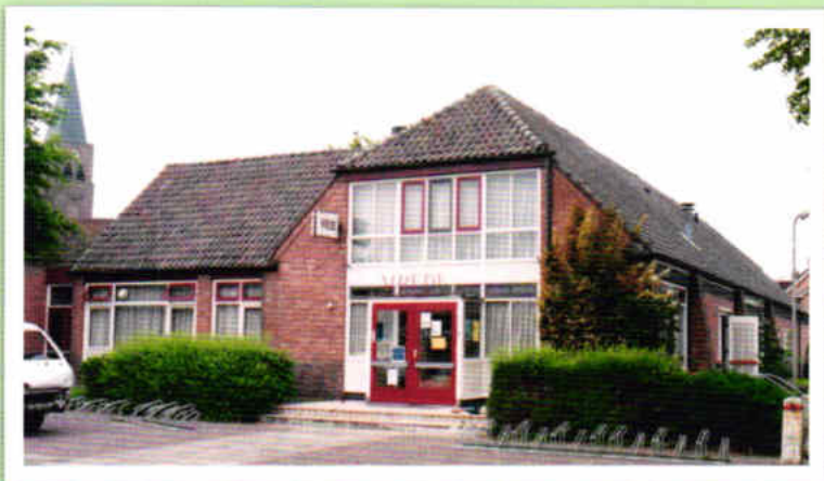
Gebouw Vrede aan de Haarstraat.
