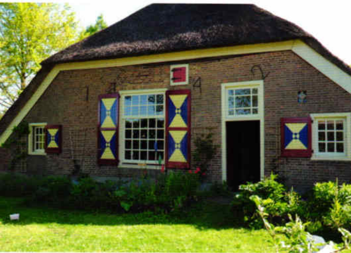
Voorgevel met muurankers met het jaartal 1742.
