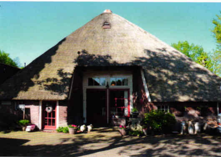
Achtergevel met onderschoer.
