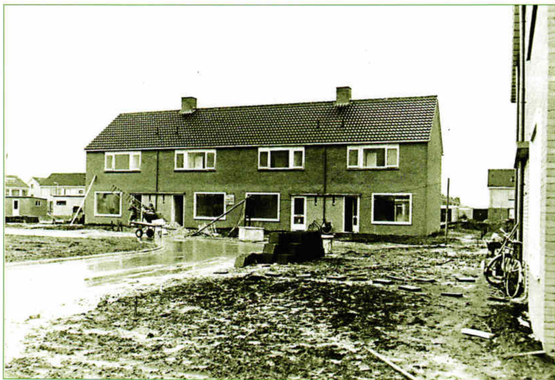
Een van de huizenblokken in aanbouw.
