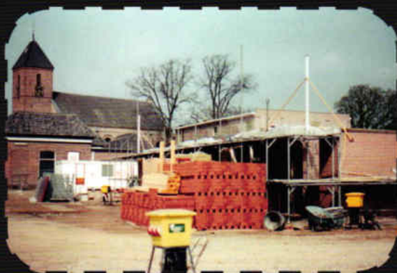
Bouw woningen Kloostermanshof
