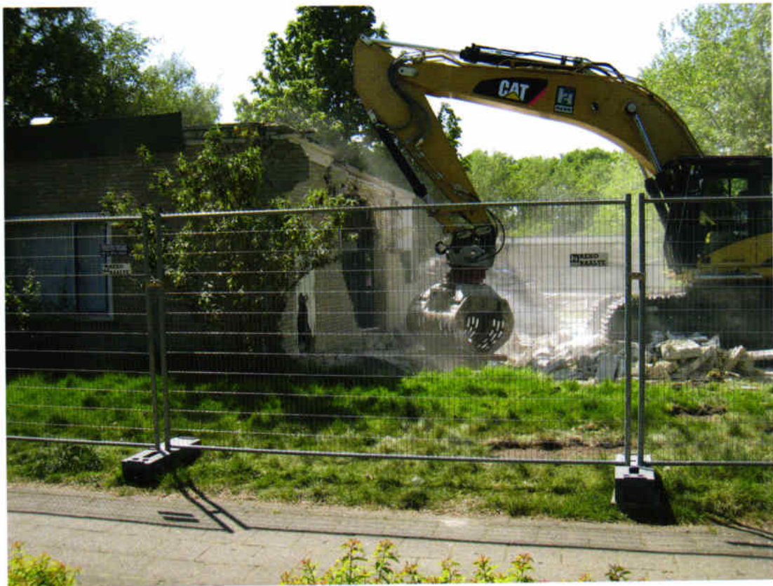
De sloop van Brinkzicht.
