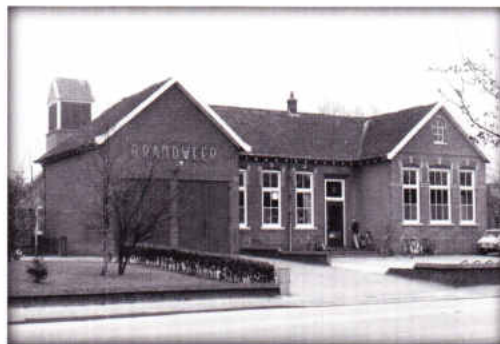
De oude brandweergarage.
