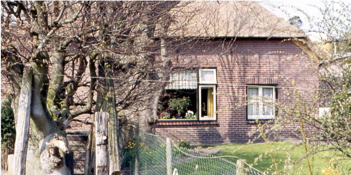
Foto uit 1985 van boerderij De Nieuwenkamp van J.A. Oosterlaar aan de Berkendijk 4
