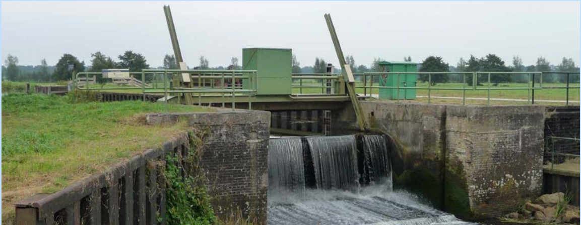
Sluis bij Langeslag 2 aan het Overijssels kanaal
