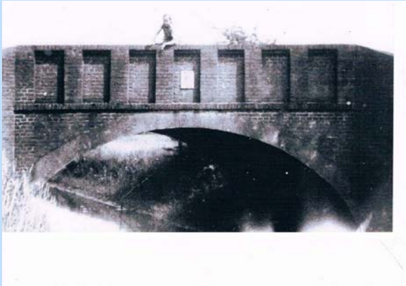
Stenen brug over de Wetering "Tijl Uilenspiegelbrug" Gebombardeerd in de Tweede Wereldoorlog
