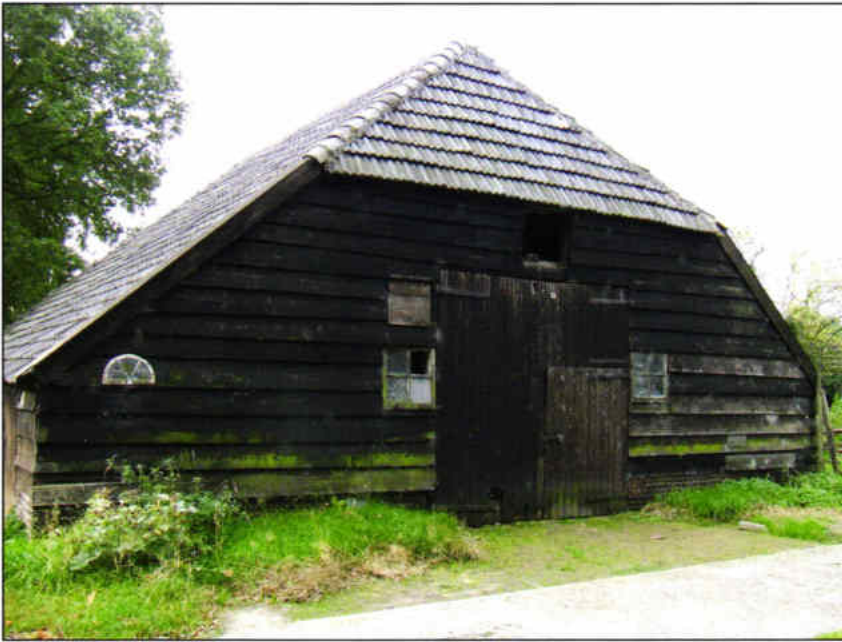
Schuur met planken en dakpannen.
