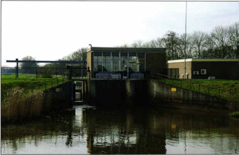
Gemaal bij Laag Zuthem. (Foto: J. Pietersen)
