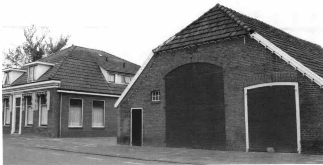
Het huis en schuur aan de Dorpsstraat.
