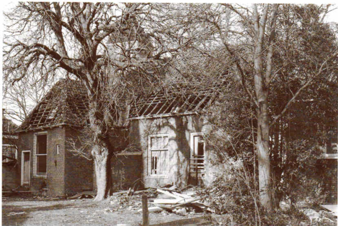
Restauratie van het 'pand De Nekker', Canadastraat 6-8.
