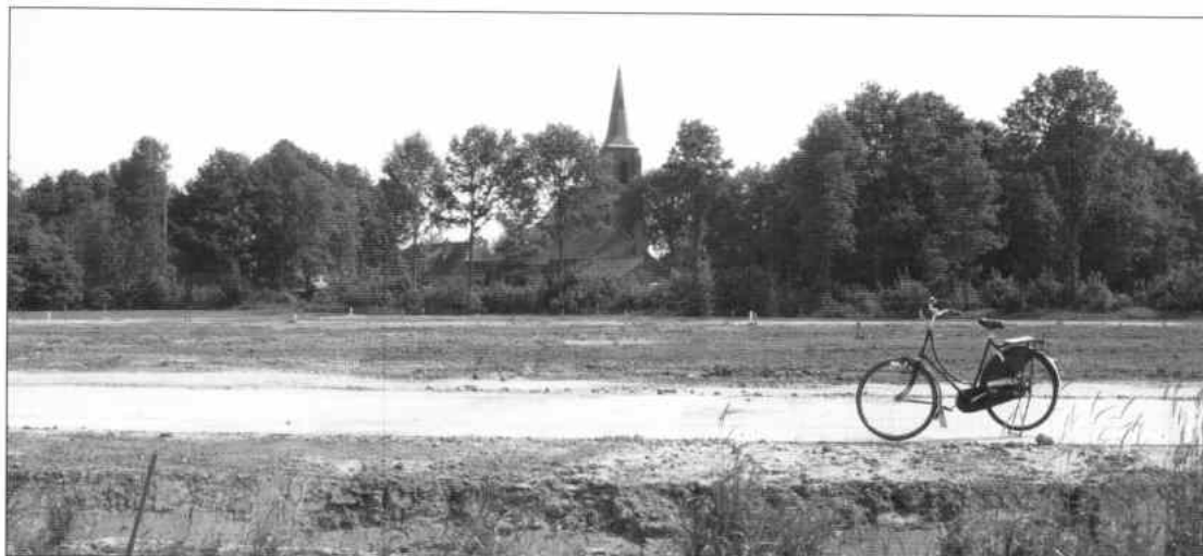
Het Lierderbroek, Molenbroek en Molenerven in aanbouw (eigen foto).
